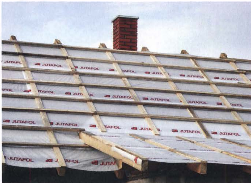
Для обеспечения гидроизоляции металлочерепицы используют паропроницаемую подкровельную пленку, укладываемую под настил кровли.
