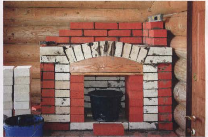
На 20-м ряду сделан арочный свод топки, а с 21-го по 28-й ряд сформирован дымоборник.
