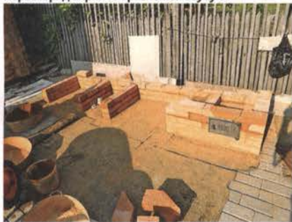
Перекрывать проем зольника лучше в замок.
