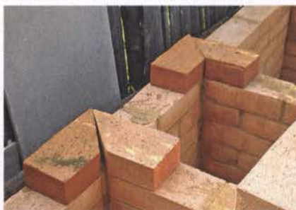
Кирпич в местах стыка стенок пилю от угла к середине, что позволяет получить надежную перевязку швов.
