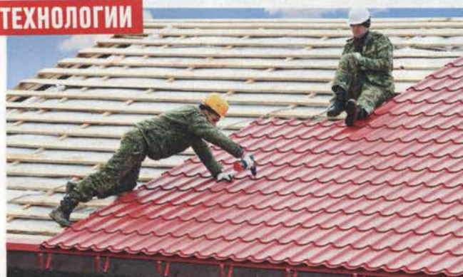
УКЛАДКА МЕТАЛЛОЧЕРЕПИЦЫ: ПРОСТЫЕ ПРАВИЛА С. 46
