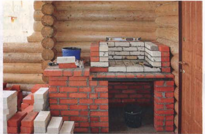
Формирование топки барбекю из шамотного и печного кирпича.
