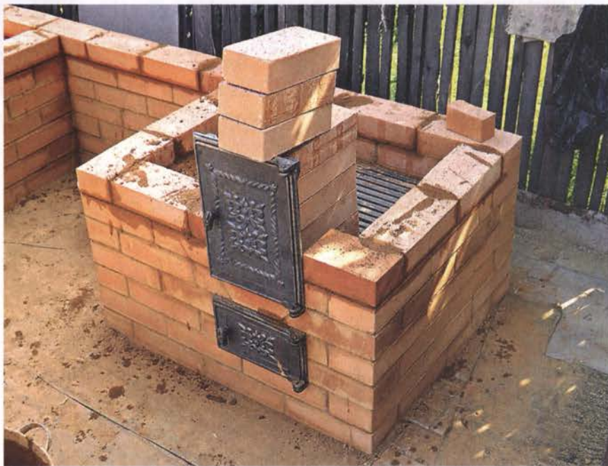
Топочную дверку на время кладки нужно надежно зафиксировать.
