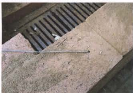
Дверки креплю в кладке проволокой, которую завожу не в швы, а в просверленные в кирпиче отверстия. Колосники ставлю по всей длине топки.
