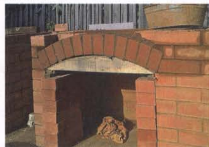
Арку выкладываю по самодельному кружалу.
