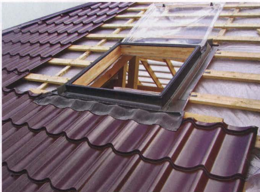
Установка мансардного окна в металлочерепицу требует качественной гидроизоляции.
