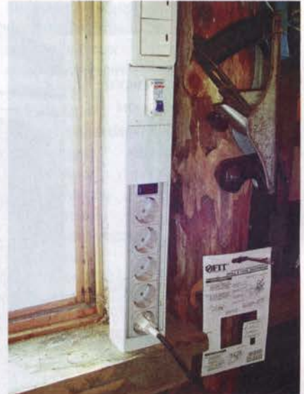
Фото 1. Общий вид стойки с электророзетками.
