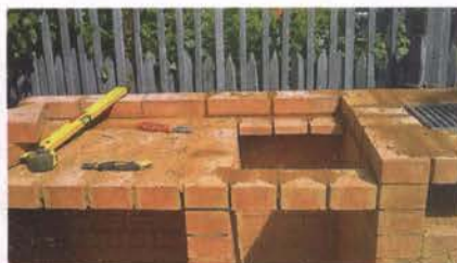
Будущий разделочный стол с проемом для установки раковины подготовлен.
