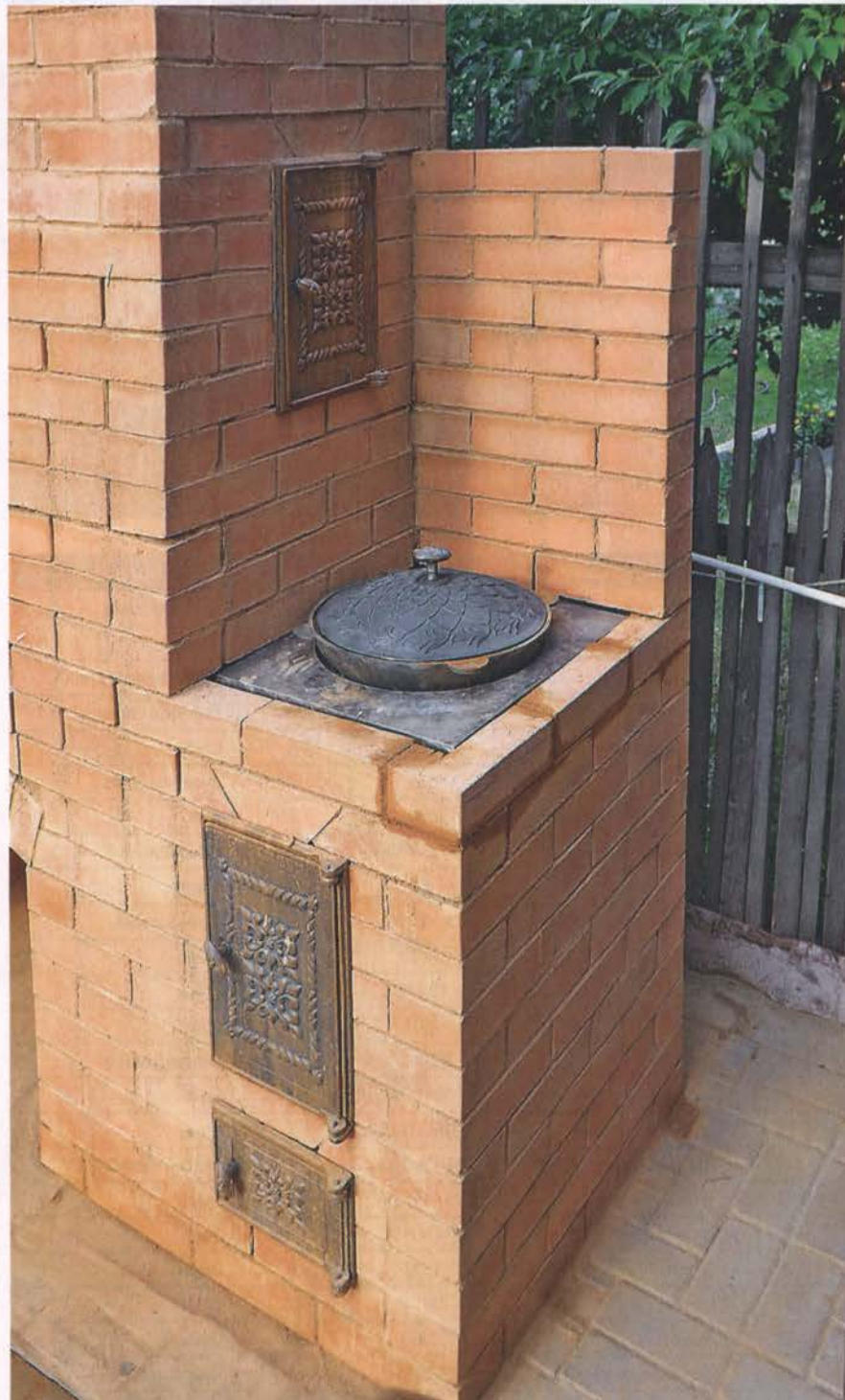
Плита и казан заняли свое место. Выше — дверка коптильной камеры.
