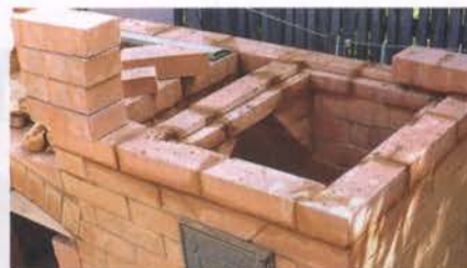
Для варочной плиты в кирпичах выбраны четверти.
