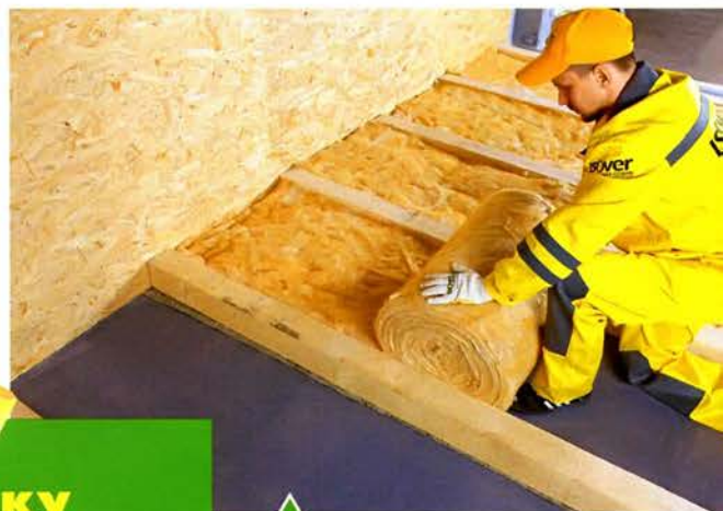
Укладка рулонного утеплителя Isover
