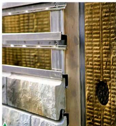
Монтаж вентилируемого фасада White Hills
