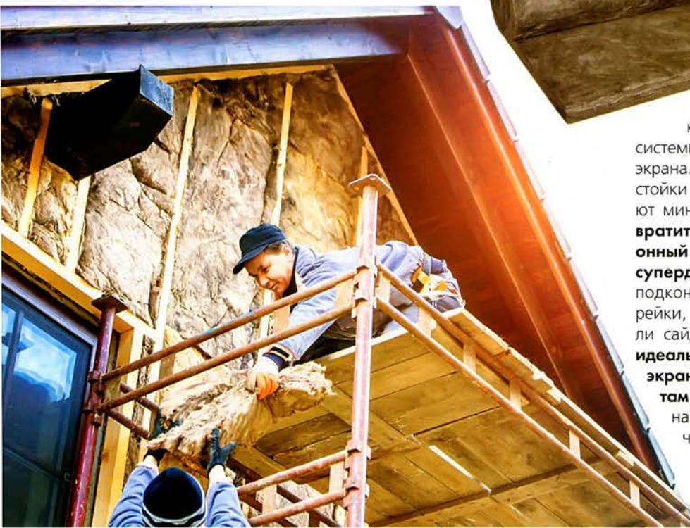
Монтаж вентилируемого фасада White Hills
