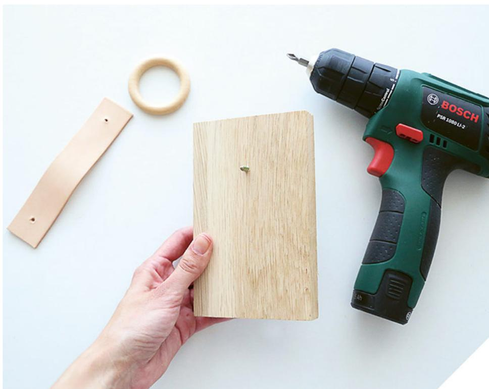
9 Commencez à visser la grande vis de 5 cm au dos de la base, dans le trou n° 2, en la faisant légèrement dépasser sur le devant.
