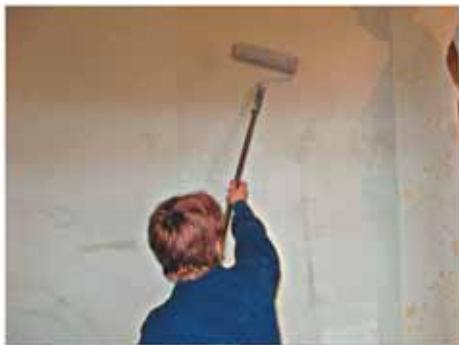
Вырезать «крест» под розетки. Намазать стену под следующее полотнище и наклеить второе полотно рядом с первым,
