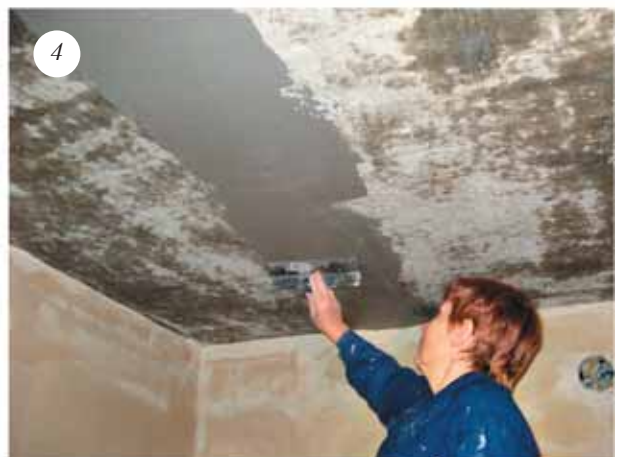
Загладить руст в «ноль» на плиты перекрытия
