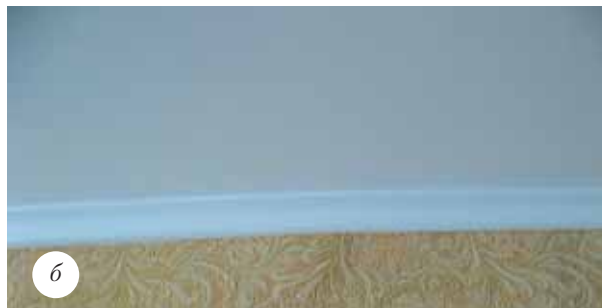
Рис. 102. Выравнивание карниза: а — клиньями; б — огибание кривой стены
