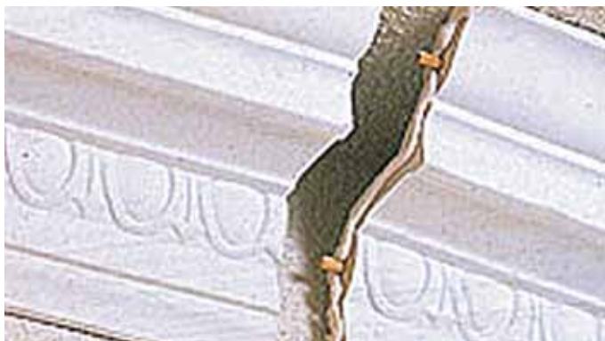
Фото 82. Крепление деталей карниза на клею и нагелях
