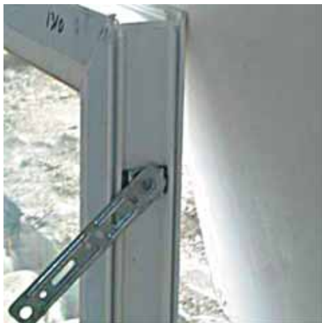
Прикрутить к раме монтажную пластину
