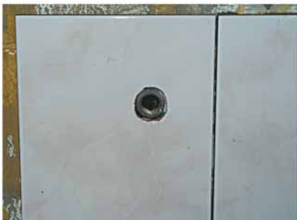
Фото 68. Пример устройства в плитке отверстий
