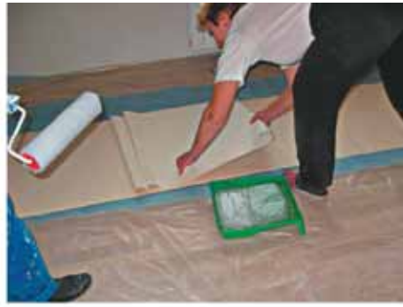
Нанести клей на обои, сложить их клеевой стороной внутрь и оставить на пропитку
