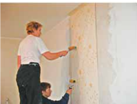
Прижать выровненный край и прикатать к стене. Прикатать середину полотна. От середины и края прикатать обои вверх
