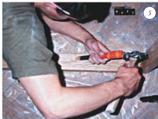
Фото 53. Установка дверных навесок (нумерация соответствует нумерации в тексте)
