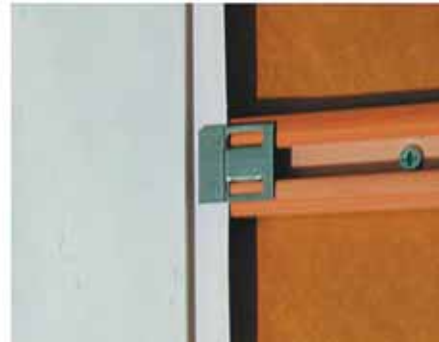
Фото 65. Варианты крепления стеновых панелей и доборных профилей:
