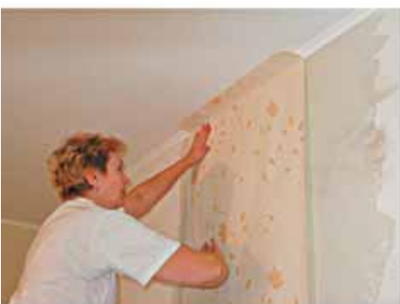
Приложить кусок обоев к стене, ровняя его одним краем по черте. Проверить вертикальность отвесом еще раз
