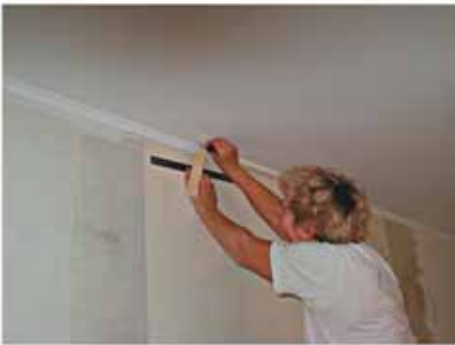
придвигая его вплотную и ровняя стык. Прикатать стык двух полотен. Приклеить все полотно, подрезать верх
