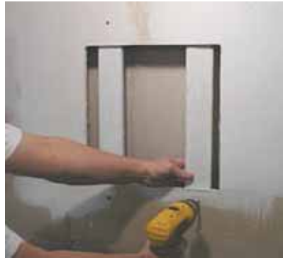
Фото 38. Заделка больших отверстий в гипсокартонной обшивке
