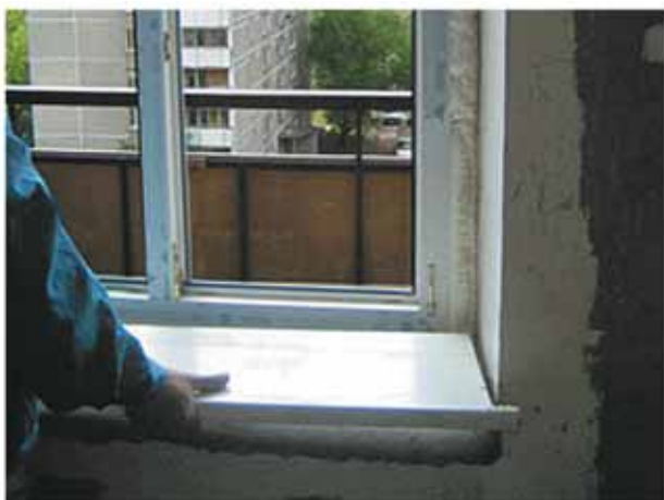
Выпилить и установить подоконник, заводя его под раму
