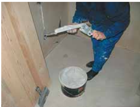
Наложить шпаклевку на шпатель
