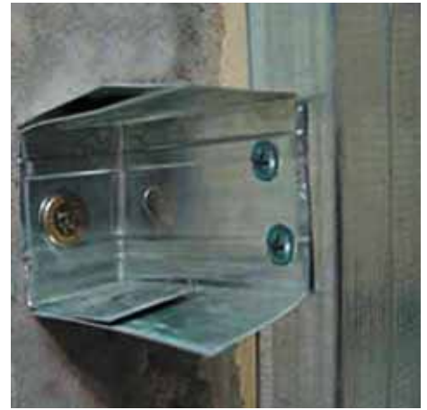
Фото 35. Крепление каркаса обрезками профилей
