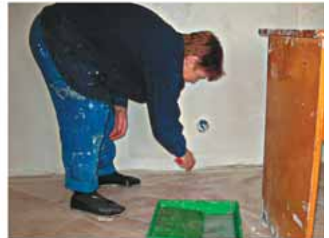
Нанести клей на стену, под карнизом и в месте крепления плинтуса (работать валиком и плоской кистью )
