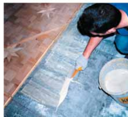
Нанесение клея шпателем
