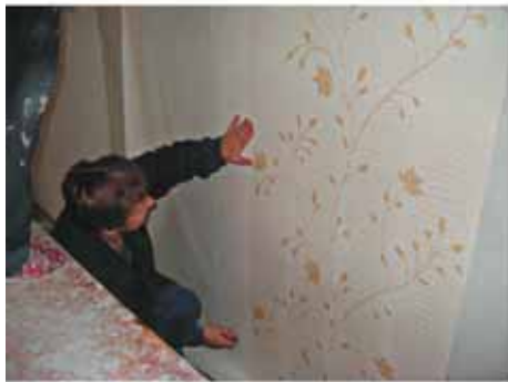
придвигая его вплотную и ровняя стык. Прикатать стык двух полотен. Приклеить все полотно, подрезать верх
