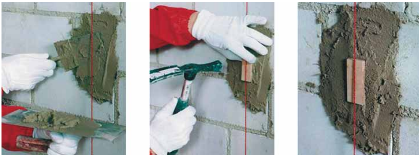
Фото 25. Установка растворных маяков
