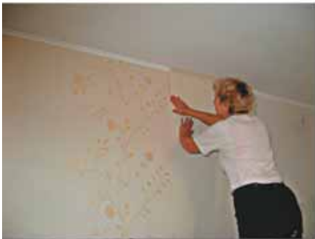
Продолжить наклейку обоев в правую сторону от центра стены. В угол вставить полотно с нахлестом на другую стену 20–40 мм
