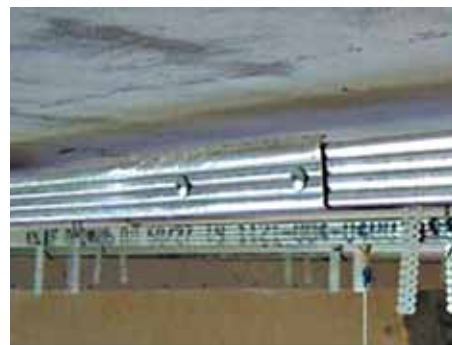
При необходимости удлините потолочные (ПП) профили
