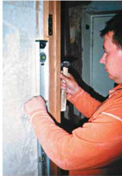
Проверить вертикальность в двух плоскостях
