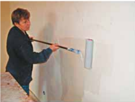
Нанести клей на стену, под карнизом и в месте крепления плинтуса (работать валиком и плоской кистью )
