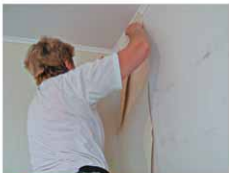
Опытные мастера могут позволить себе клеить в угол целое полотнище и подрезать его по ширине прямо на стене. Подрезка ведется «в угол»
