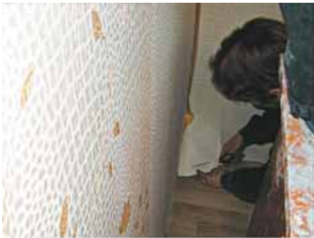
Здесь обои удобнее подрезать ножницами. Вдавить полотно в угол шпателем или линейкой
