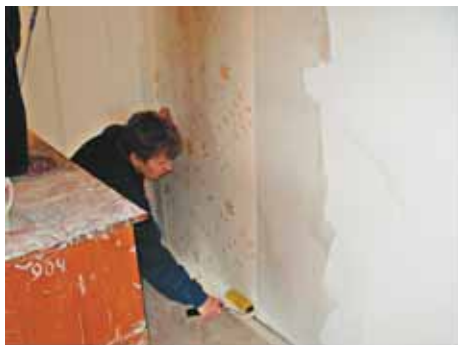
От середины и края прикатать обои вниз. Вдавить верх обоев линейкой или шпателем к потолочному карнизу и подрезать
