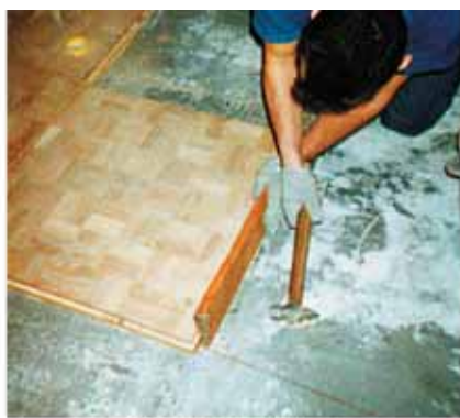
Сплачивание щитов
