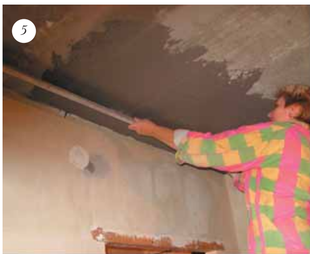
Намет вытягивается и выравнивается «на себя» алюминиевым правилом
