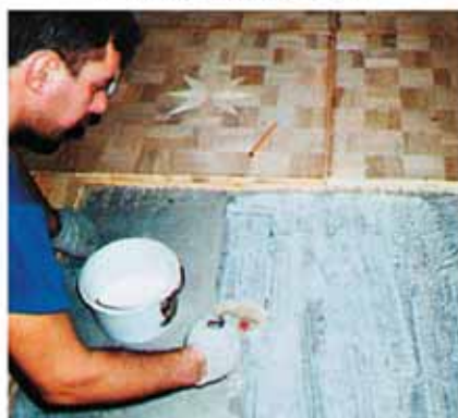
Нанесение грунтовки
