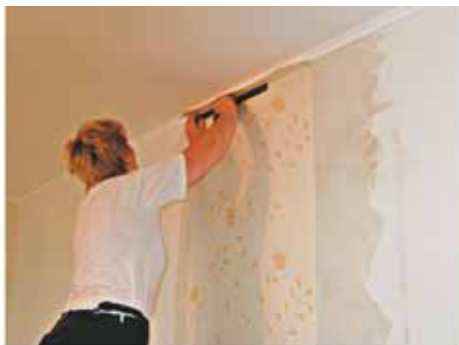
От середины и края прикатать обои вниз. Вдавить верх обоев линейкой или шпателем к потолочному карнизу и подрезать
