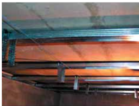
Набросьте на профили прямые подвесы и раздвиньте их с соответствующим шагом
