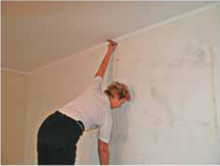
Отвесом вынести на стену вертикаль и отметить ее. Проверить вертикаль уровнем
