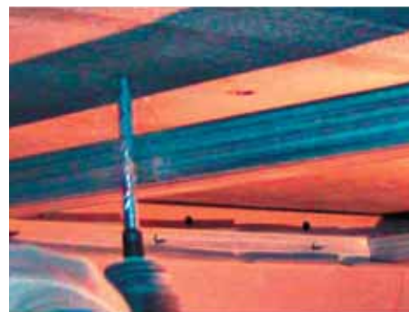
Наметьте местонахождение подвесов и установите их, сдвинув профиль ПП
