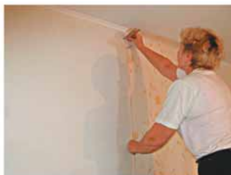
Приложить кусок обоев к стене, ровняя его одним краем по черте. Проверить вертикальность отвесом еще раз
