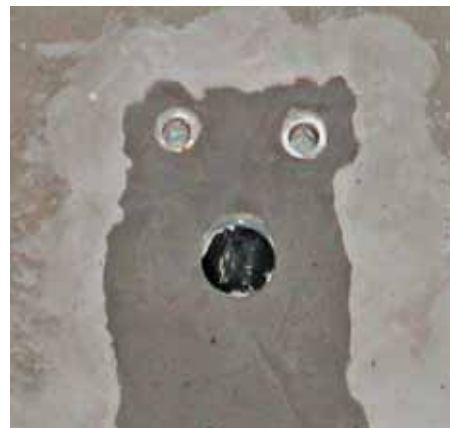
Фото 97. Розетка подключения сантехнических приборов
