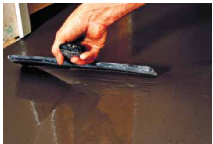
Фото 42. Укладка самовыравнивающих смесей
