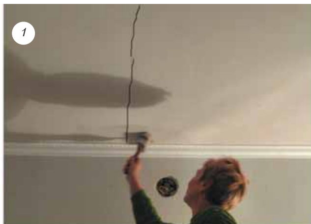
1 Чтобы не сбиться при наклеивке полосы стеклохолста, нарисуйте под рустами линию
