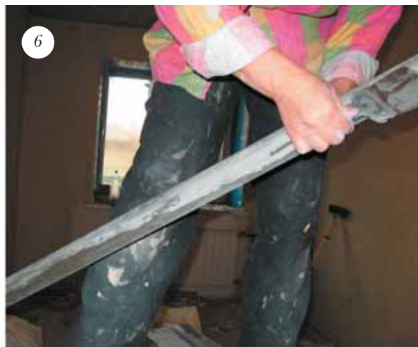
Снятый с потолка «лишний» раствор счищается и отправляется обратно в ёмкость.
