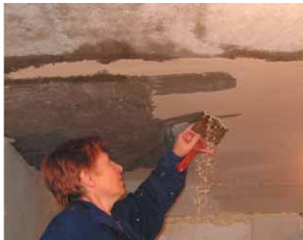
Фото 70. Подготовка потолка: размягчить старое покрытие теплой водой и счистить шпателем
