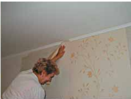
Вырезать «крест» под розетки. Намазать стену под следующее полотнище и наклеить второе полотно рядом с первым,
