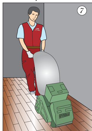
7 Прошлифовать паркет машинами различными видами
