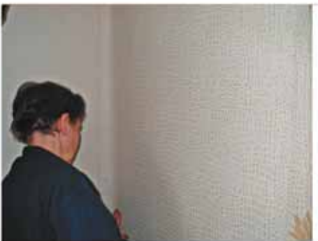
Неприклеенные стыки отогнуть, промазать клеем и приклеить. В угол так вклеить полотно, чтобы оно заворачивалось на 20–40 мм
