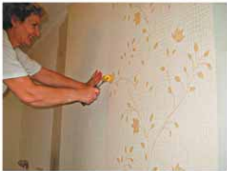
придвигая его вплотную и ровняя стык. Прикатать стык двух полотен. Приклеить все полотно, подрезать верх
