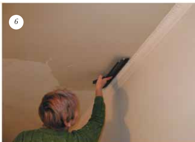
6 и шпаклюют 2 слоем Шитрока, после очередного шлифования потолок готов под покраску
