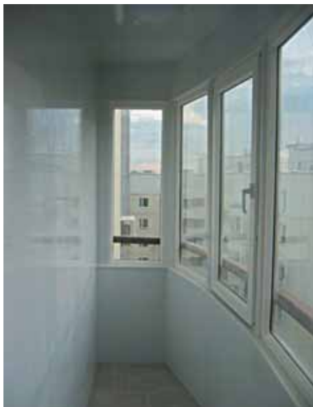
Фото 63. Облицовка панелями ПВХ
