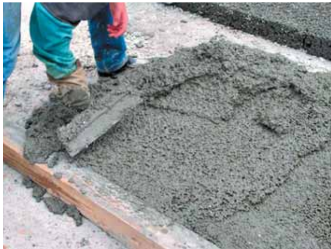
Фото 45. Устройство стяжки из пенополистиролбетона
