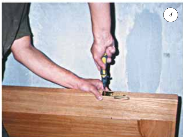
Фото 53. Установка дверных навесок (нумерация соответствует нумерации в тексте)
