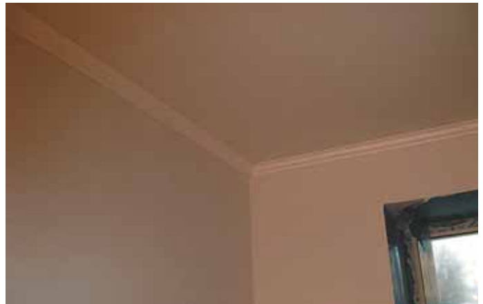
Фото 34. Шпаклевание вторым слоем
