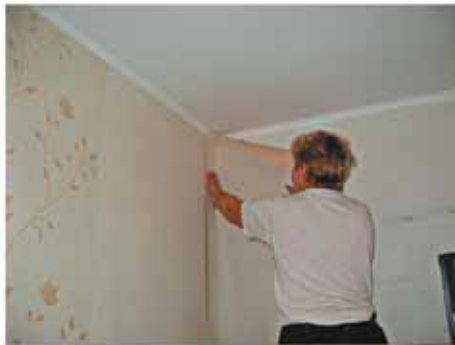
Продолжить наклейку обоев в правую сторону от центра стены. В угол вставить полотно с нахлестом на другую стену 20–40 мм
