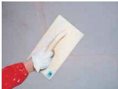
Затереть трещину теркой, притирая границы
