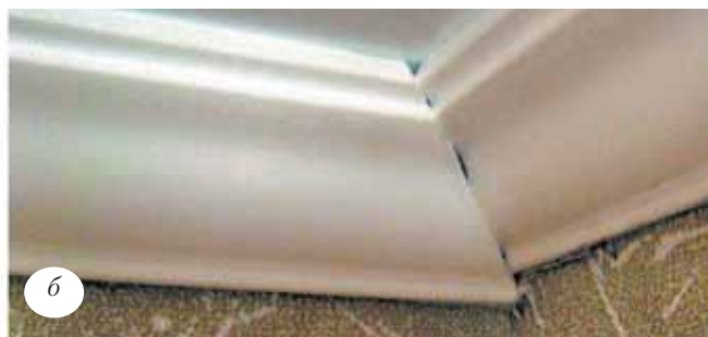
Фото 78. Установка карниза: а — правильно установленный карниз и правильно запиленное угловое соединение (соединение будет подшпаклевано, а карниз окрашен вместе с потолком); б — неправильно установленный карниз (установлен после обоев, угол запилен неверно, его практически невозможно зашпаклевать, а запил угла уже не исправить)
