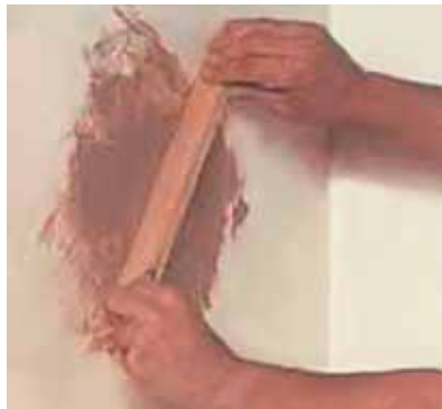
Фото 36. Ремонт повреждений лицевого слоя гипсокартонных листов
