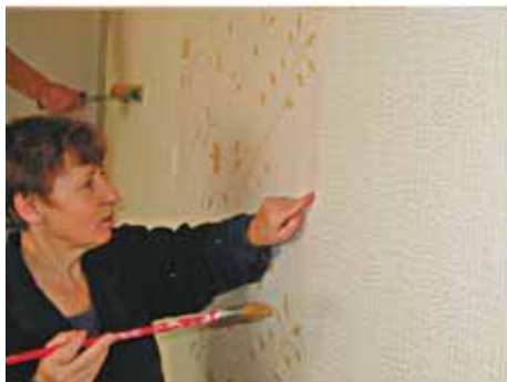
Неприклеенные стыки отогнуть, промазать клеем и приклеить. В угол так вклеить полотно, чтобы оно заворачивалось на 20–40 мм
