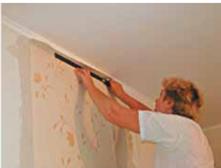
От середины и края прикатать обои вниз. Вдавить верх обоев линейкой или шпателем к потолочному карнизу и подрезать
