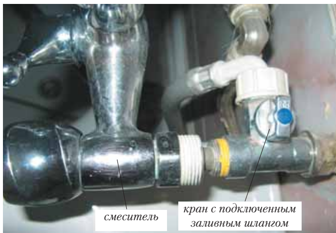
Рис. 104. Подключение стиральной машины к смесителю
