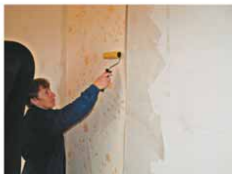
Прижать выровненный край и прикатать к стене. Прикатать середину полотна. От середины и края прикатать обои вверх
