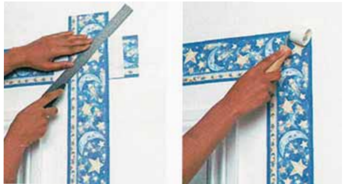
Фото 57. Наклеивание бордюра вокруг проемов
