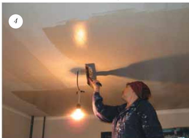
4 После высыхания стеклохолста потолок шпаклюют шпаклевкой Шитрок первым слоем
