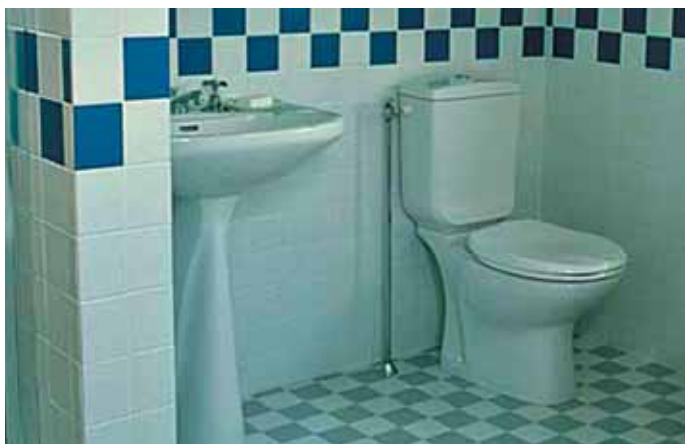
Фото 101. Подключение бачка декоративной подводкой
