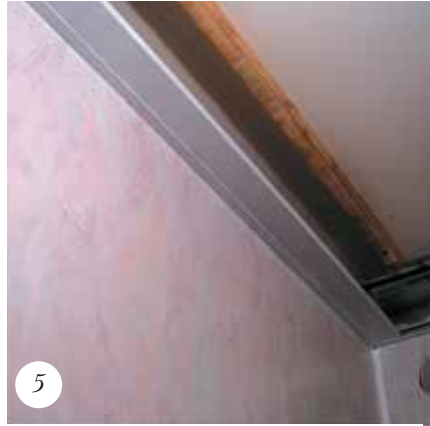
Установите пристенные профили и смонтируйте крайнюю рейку
