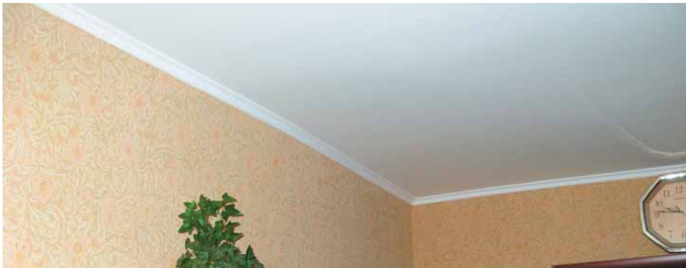
Фото 75. Штукатурный потолок в спальне квартиры. Сделан три года назад: произведено выравнивание плит перекрытия, перепад высот был 40–50 мм, русты армированы серпянкой (по плитам перекрытия) и полосами стеклохолста в нижнем слое. Потолок штукатурился Ротбандом в два слоя и шпаклевался Ветонитом в один слой. Горизонтальность потолка не исправлялась. На потолке ни одной трещинки, а выглядит он так, как будто сделан вчера
