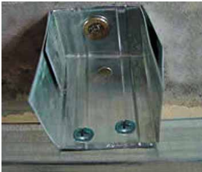
Фото 91. Самодельный подвес из обрезка профиля
