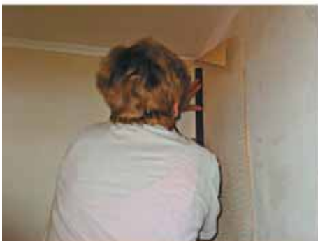
Опытные мастера могут позволить себе клеить в угол целое полотнище и подрезать его по ширине прямо на стене. Подрезка ведется «в угол»
