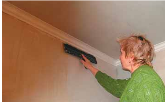
Фото 33. Если стена не очень кривая (или вас устраивает ее ровность), то под оклейку толстыми обоями ее можно зашпаклевать только по периметру, растягивая шпаклевку «в ноль» от углов стен, потолка и пола
