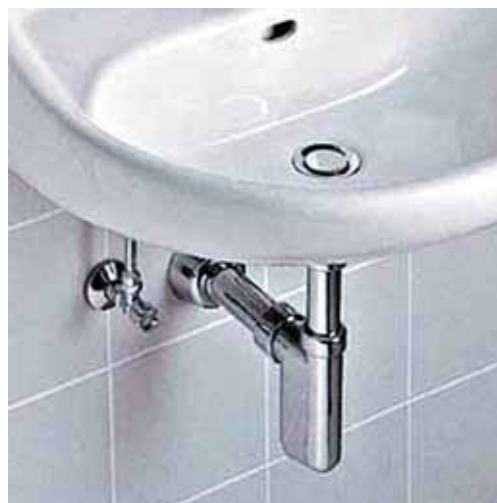
Фото 98. Пример подключения раковины
