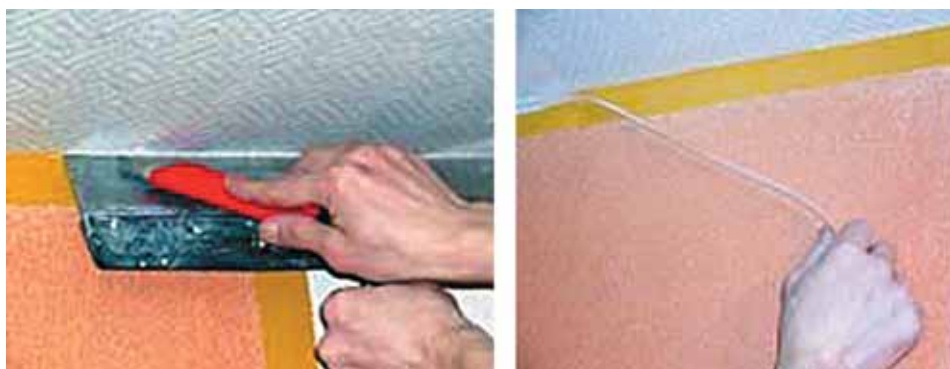
Фото 81. Подрезка обоев в углу, образованном стеной и потолком
