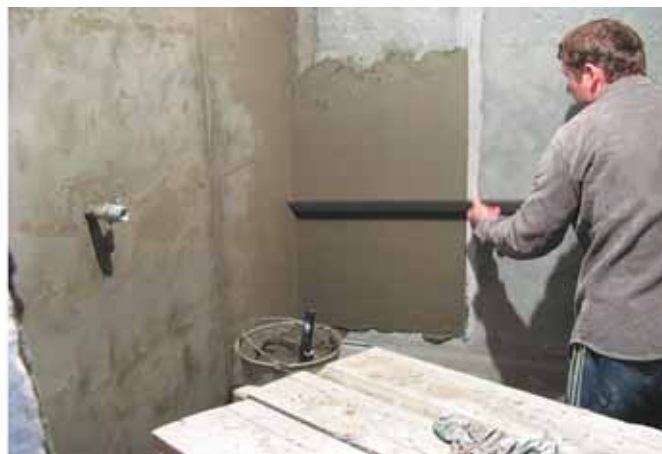
Фото 30. Нанесение второго слоя штукатурки с выравниванием
