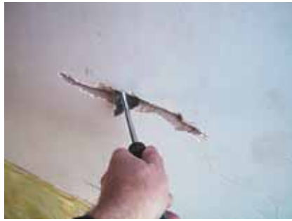
Обнаружить и расшить трещины
