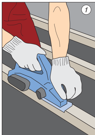
1 Установить и пристрогать лаги
