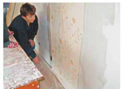
Приложить кусок обоев к стене, ровняя его одним краем по черте. Проверить вертикальность отвесом еще раз
