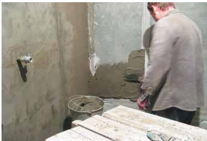
Фото 30. Нанесение второго слоя штукатурки с выравниванием
