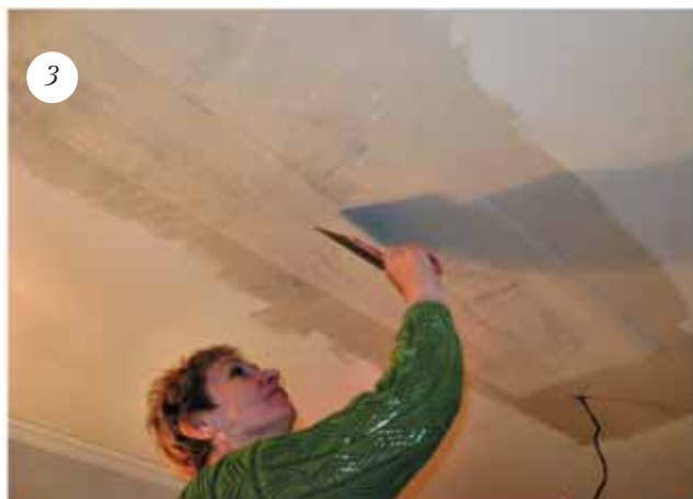
3 вдавите его шпателем в слой клея и ровно разгладьте
