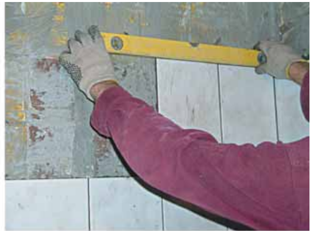
Периодически проверять ровность укладки плитки уровнем и правилом
