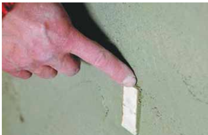
Фото 29. Толщина первого слоя штукатурки должна быть ниже маяков (любого типа) примерно на 5 мм
