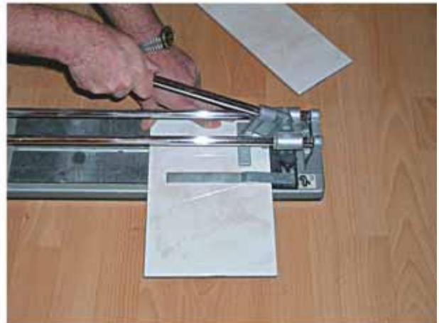
При необходимости под плитку добавлять клей или, наоборот, осаживать плитку легкими ударами резинового молотка. Обрезать и надламывать плитку удобнее в плиткорезе
