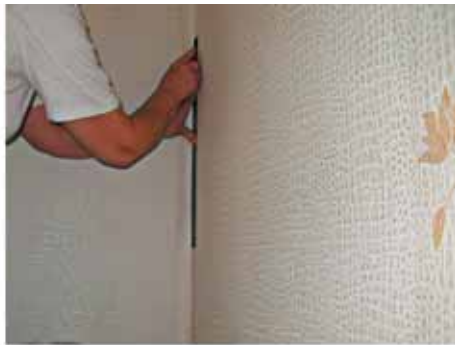
Здесь обои удобнее подрезать ножницами. Вдавить полотно в угол шпателем или линейкой
