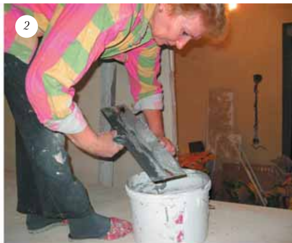
Маленьким шпателем раствор накладывается на большой
