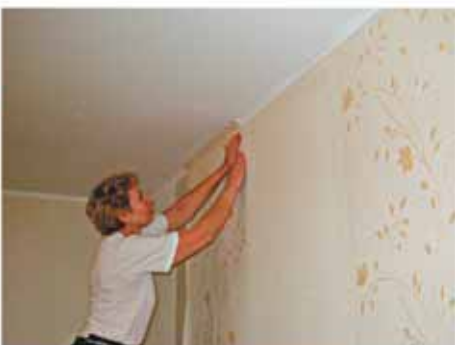
придвигая его вплотную и ровняя стык. Прикатать стык двух полотен. Приклеить все полотно, подрезать верх
