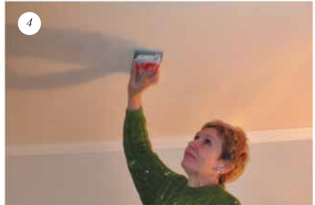
Зашлифовать высохшую поверхность
