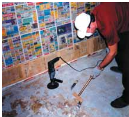
Подготовка старого основания
