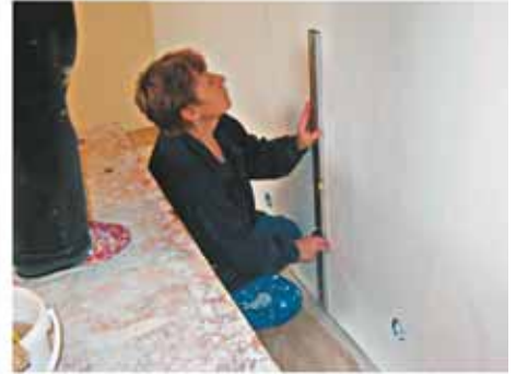
Отвесом вынести на стену вертикаль и отметить ее. Проверить вертикаль уровнем
