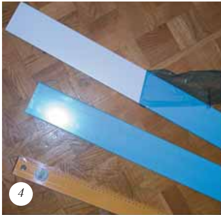
Перед монтажом снимите с реек пленку
