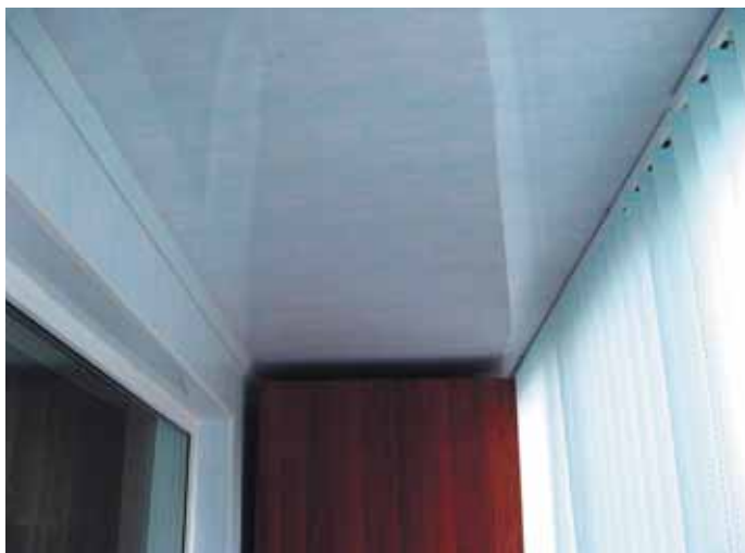
Фото 21. Подшивной потолок (из ПВХ-панелей)
