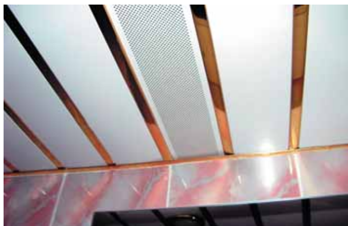
Фото 84. Устройство вентиляционной вытяжки посредством применения перфорированной рейки
