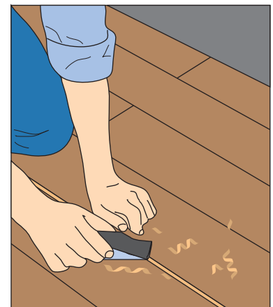
Сострогать клин заподлицо с полом
