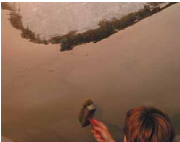
Фото 70. Подготовка потолка: размягчить старое покрытие теплой водой и счистить шпателем
