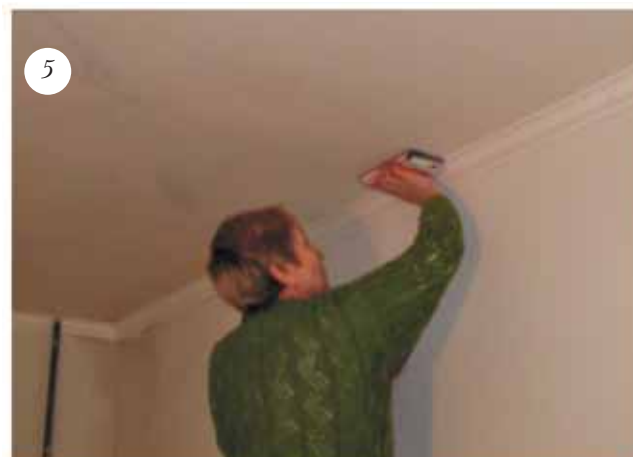
5 Высохшую поверхность шлифуют
