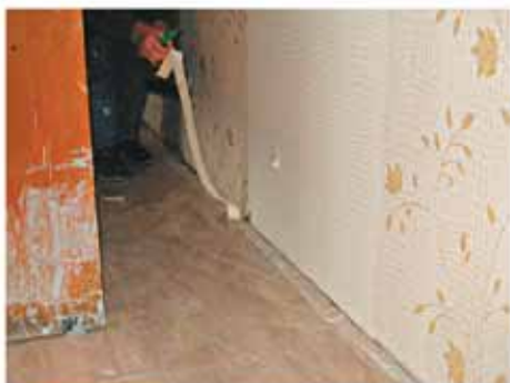
и низ обоев. Приклеить третье полотно
