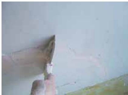
Фото 24. Мелкий ремонт штукатурки: заделка выбоин, трещин и раковин
