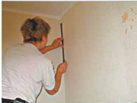
и подрезать завернутые на угол обои. Верх подработать ножницами и вдавить подрезанные обои в угол
