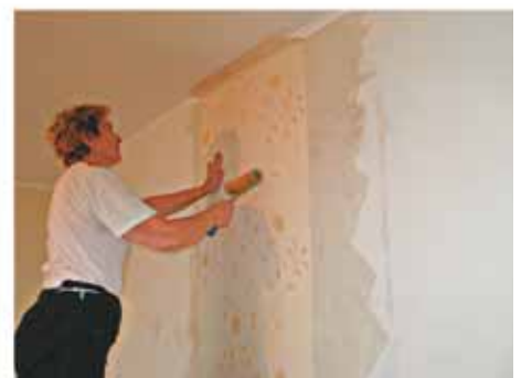
Прижать выровненный край и прикатать к стене. Прикатать середину полотна. От середины и края прикатать обои вверх
