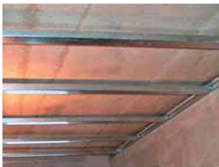
Уложите в пристенные профили (ППП) потолочные (ПП) профили и раздвиньте их с соответствующим шагом
