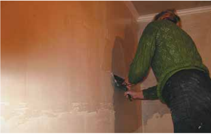
Фото 33. Если стена не очень кривая (или вас устраивает ее ровность), то под оклейку толстыми обоями ее можно зашпаклевать только по периметру, растягивая шпаклевку «в ноль» от углов стен, потолка и пола
