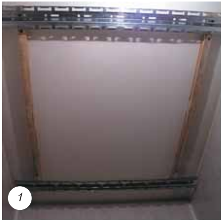
Установите деревянные рейки и прикрепите к ним стрингеры
