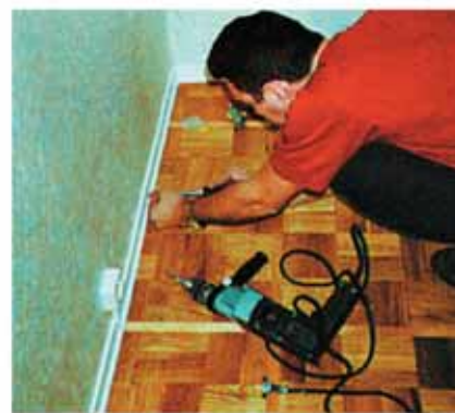
Установка плинтусов
