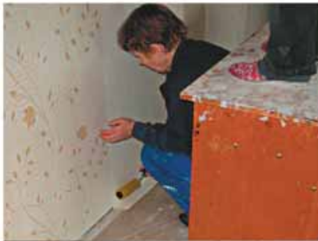
Продолжить наклейку обоев в правую сторону от центра стены. В угол вставить полотно с нахлестом на другую стену 20–40 мм
