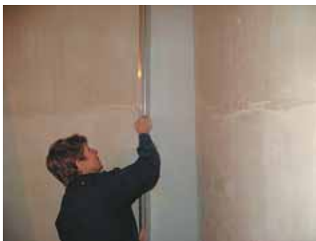
Разровнять шпаклевку правилом
