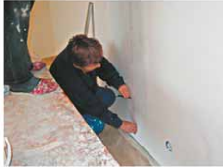
Отвесом вынести на стену вертикаль и отметить ее. Проверить вертикаль уровнем
