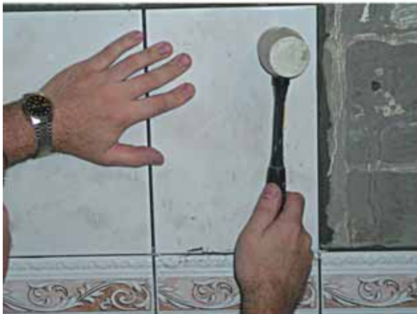
При необходимости под плитку добавлять клей или, наоборот, осаживать плитку легкими ударами резинового молотка. Обрезать и надламывать плитку удобнее в плиткорезе
