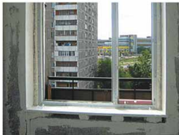
Для придания подоконнику уклона установить клинья
