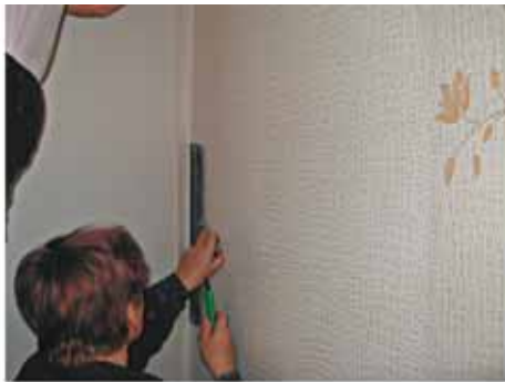
Здесь обои удобнее подрезать ножницами. Вдавить полотно в угол шпателем или линейкой
