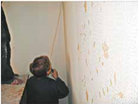
и подрезать завернутые на угол обои. Верх подработать ножницами и вдавить подрезанные обои в угол
