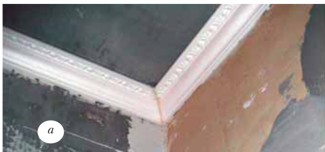
Фото 78. Установка карниза: а — правильно установленный карниз и правильно запиленное угловое соединение (соединение будет подшпаклевано, а карниз окрашен вместе с потолком); б — неправильно установленный карниз (установлен после обоев, угол запилен неверно, его практически невозможно зашпаклевать, а запил угла уже не исправить)
