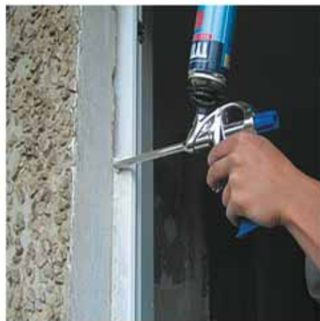
Щели со стороны улицы заполнить герметиком
