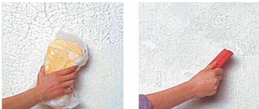
Фото 60. Простое текстурирование окраски с помощью губки и гребня
