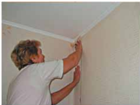
Неприклеенные стыки отогнуть, промазать клеем и приклеить. В угол так вклеить полотно, чтобы оно заворачивалось на 20–40 мм
