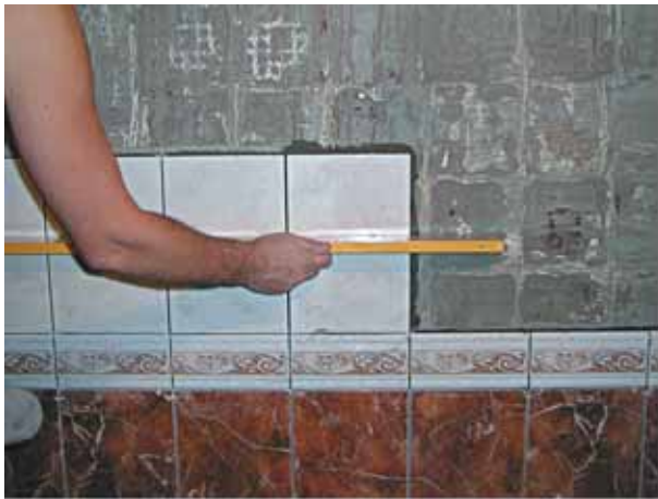
Периодически проверять ровность укладки плитки уровнем и правилом
