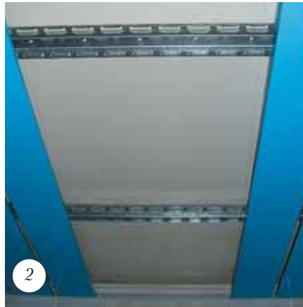
Установите по краям рейки и выставьте по ним торцевые профили
