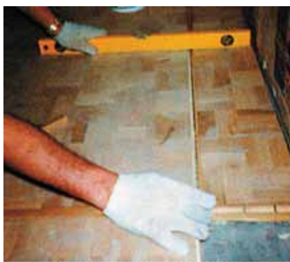
Установка щитов с проверкой
