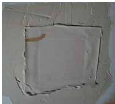
Фото 37. Заделка небольших отверстий в гипсокартонной обшивке
