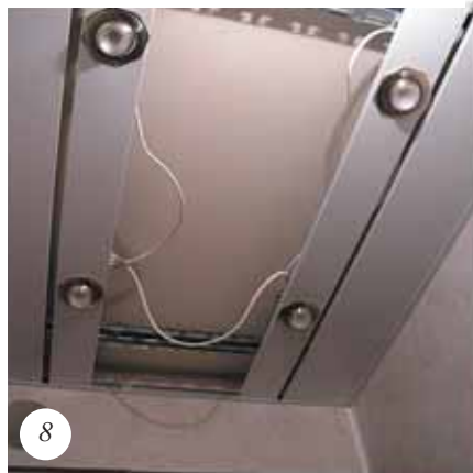
Установите рейки со светильниками
