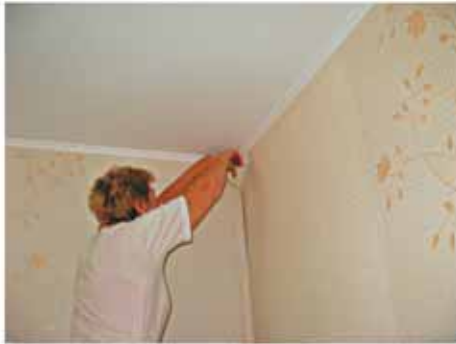
и подрезать завернутые на угол обои. Верх подработать ножницами и вдавить подрезанные обои в угол
