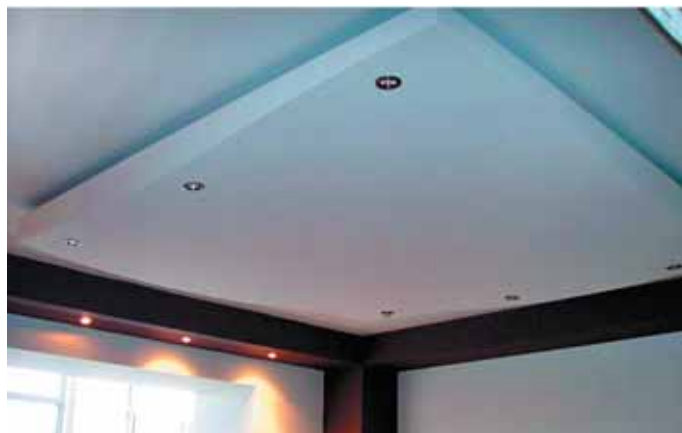
Рис. 127. Устройство короба с отступом от стены
