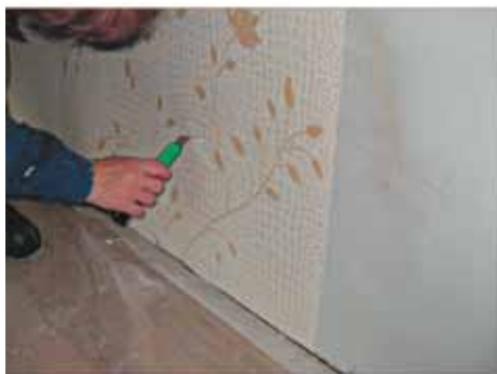
Вырезать «крест» под розетки. Намазать стену под следующее полотнище и наклеить второе полотно рядом с первым,
