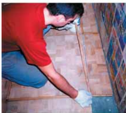
Укладка планок между щитами
