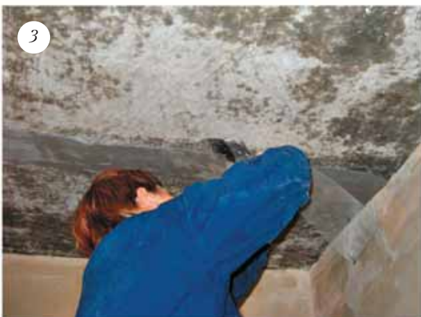
Вдавить серпянку, разравнивая ее шпателем
