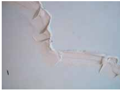
Смочить трещины грунтовкой или водой и заполнить ремонтной смесью
