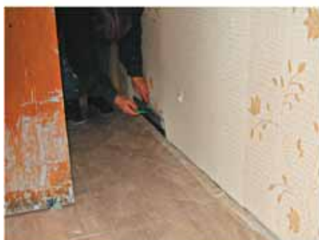
придвигая его вплотную и ровняя стык. Прикатать стык двух полотен. Приклеить все полотно, подрезать верх
