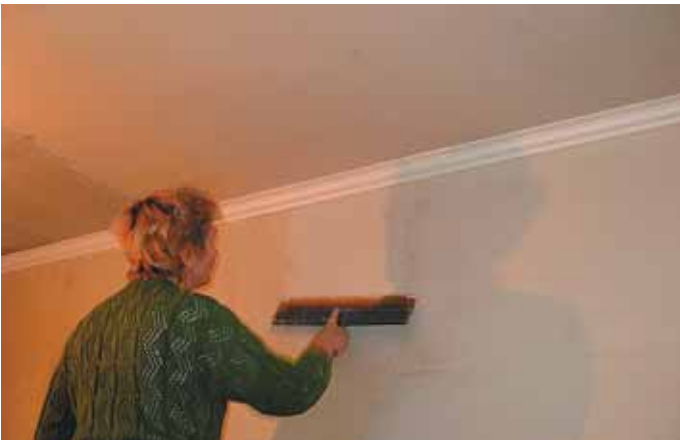
Фото 34. Шпаклевание вторым слоем
