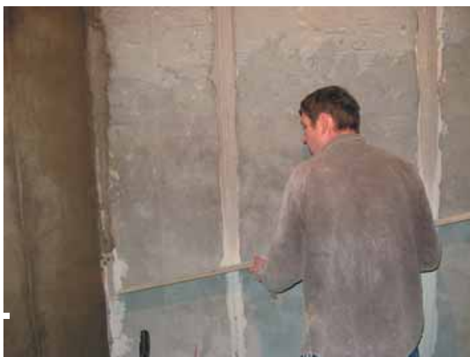
Фото 27. Проверка толщины штукатурного намета по «вмороженным» маякам
