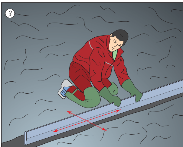
Между двух "пяточков" натереть растворный маяк - "грядку"
