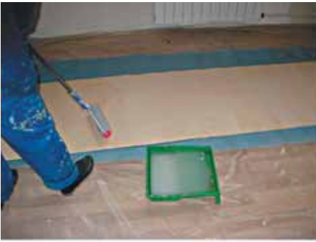
Нанести клей на обои, сложить их клеевой стороной внутрь и оставить на пропитку
