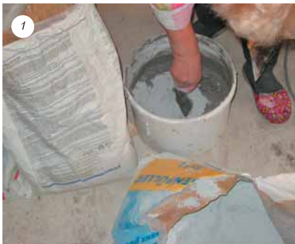
Замешивайте столько раствора, сколько сможете выработать за полчаса
