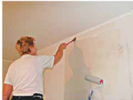
Нанести клей на стену, под карнизом и в месте крепления плинтуса (работать валиком и плоской кистью )
