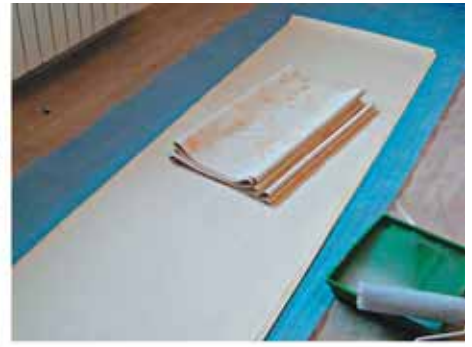
Нанести клей на обои, сложить их клеевой стороной внутрь и оставить на пропитку
