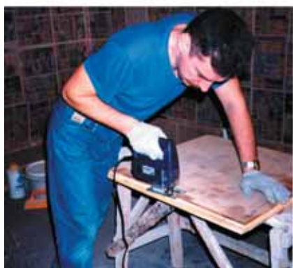
Обрезка крайних щитов
