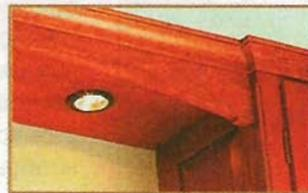
**Эффект отделки усиливается скрытыми светильниками, экранированными «мостиком».**
