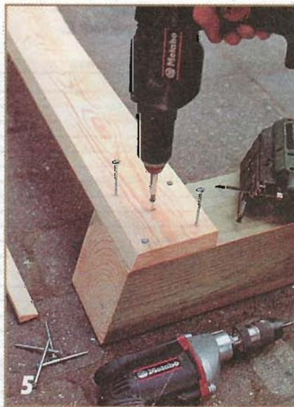
Прострогав верхнюю кромку перемычки E под тем же углом, под которым запилены стойки, деталь E крепят шурупами к стойке.
