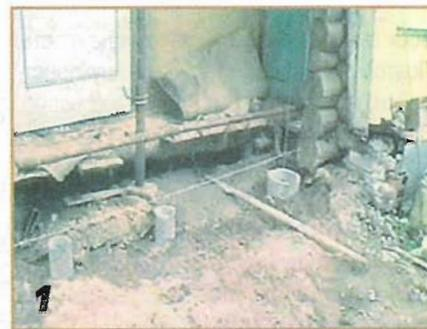
Подпорка поддерживает крышу. На снимке видны также асбоцементные трубы фундамента.
