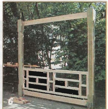
Ограждение крепят 70-мм шурупами на 50 мм выше нижней перемычки D. Заканчивают ограждение креплением 40-мм шурупами перил O.
