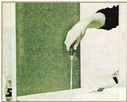
Боковые стенки шурупами соединяют с нижним горизонтальным щитом. Обратите внимание — передняя опора смещена на 20 мм внутрь относительно передней кромки горизонтального щита.
