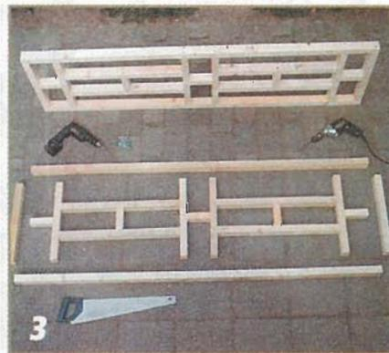
Решетчатые ограждения собираются на 80-мм шурупах. Из деталей F и H свинчивают две H-образные средние секции. По концам крепят четыре вертикальные стойки G. Затем обе под сборки соединяют средней перемычкой H и прикрепляют к ним внешние детали G. В заключение крепят верхнюю и нижнюю перемычки J.
