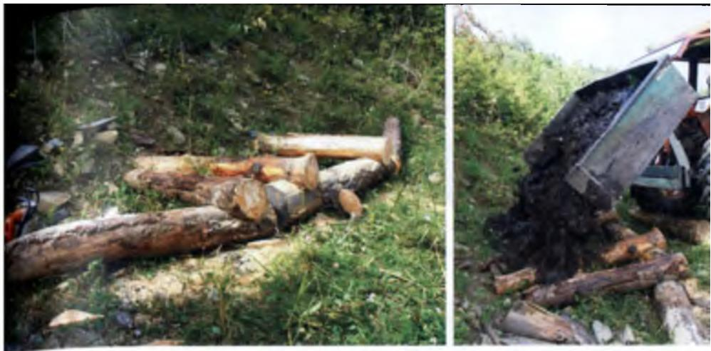
*Вверху слева: изготавление основы конструкции травяной бревенчатой подпорной гряды на Краметерхофе.*
