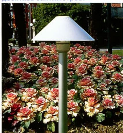
Дорожки и тропинки можно освещать с помощью фонарей средней высоты, снабженных абажуром, направляющим световой поток вниз. Этот тип фонарей, называемых грибочками, (вверху и справа) также подходит для освещения клумб или лужаек.
