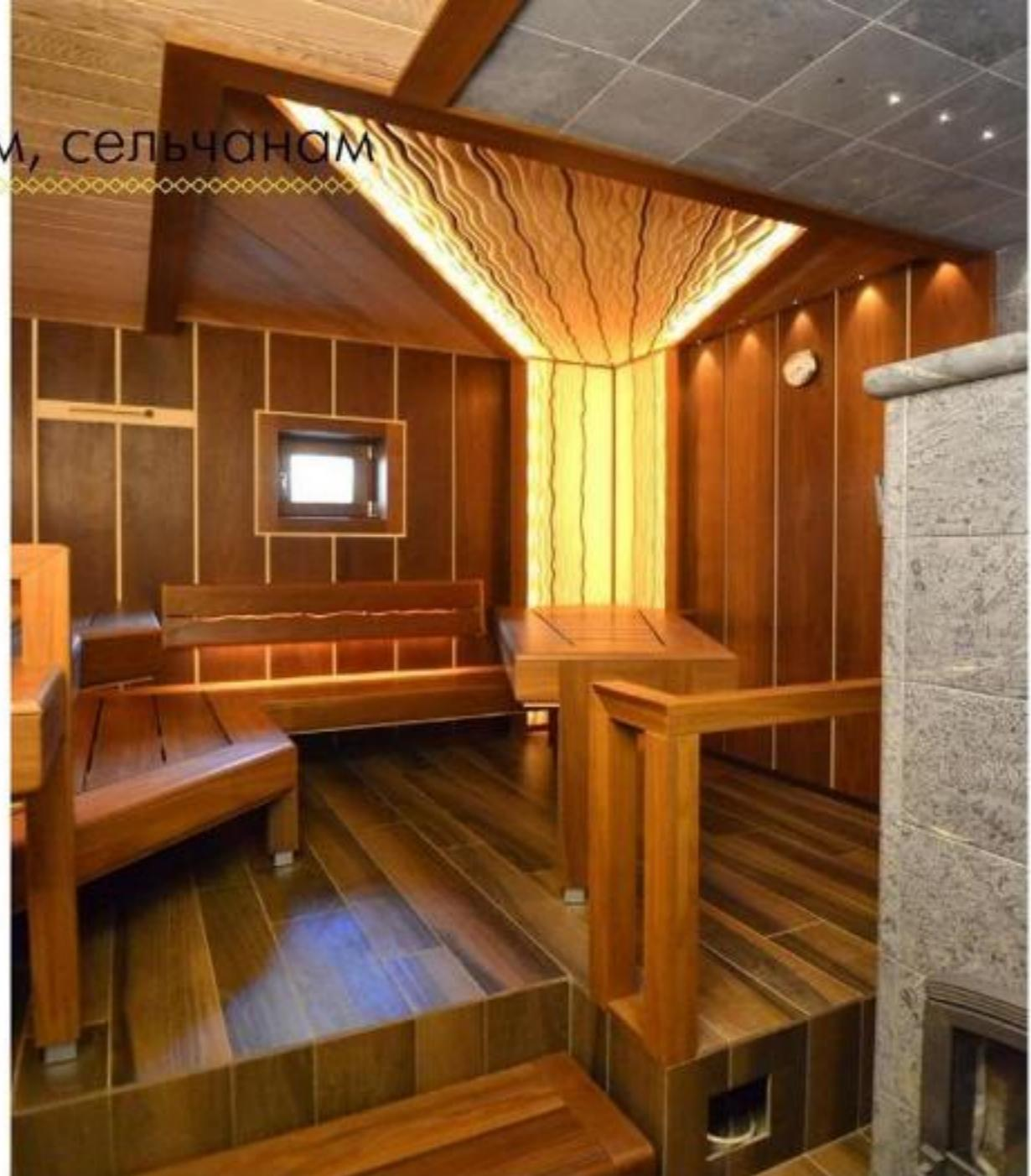
**1.** При строительстве пол залил бетоном. Из металлического профиля смонтировал каркас и облицевал его плиткой, имитируя кладку ламината (можно использовать вагонку).
