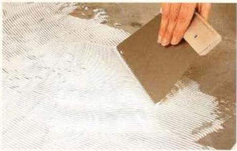
3. Двигая шпатель от центра к краям, избавьтесь от пузырьков воздуха. Удалите излишек линолеума вдоль стен с помощью резака.
