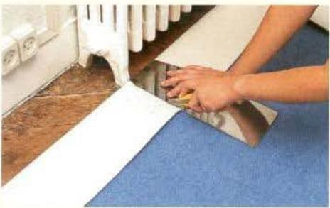
4. Возле порога разрежьте ковровое покрытие на уровне покрытия смежного помещения. Край закрепите металлическим порожком.
