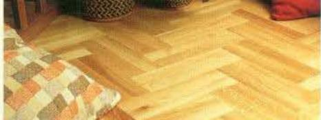
3. При «венгерской» настилке короткие планки с концами, обрезанными под углом 45°, набивают на поперечины. Они образуют V-образный рисунок. Учтите, что для настилки следует запа-
