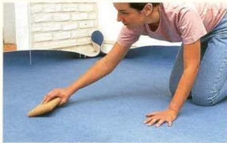
2. Произведите первый вырез на уровне плинтусов на 1–2 м посреди каждой стены помещения.
