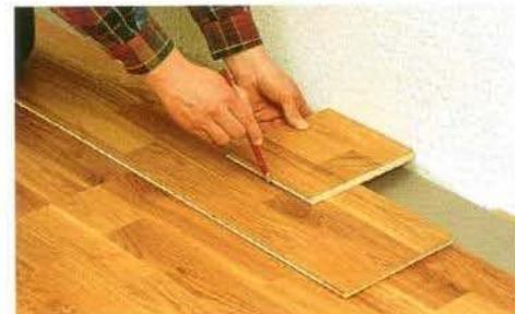
5. Ставьте последние планки, промазывая kleem лишь одну бороздку. Вставляйте их с помощью металлического упора и молотка. Сожмите их с другими планками и соблюдайте зазор между стеной и паркетом.
