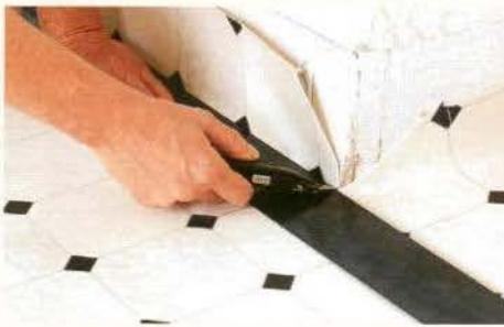
4. При укладке двух полотнищ сначала приклеивают их на  $\frac{3}{4}$  от ширины со стороны стен. Затем проклеивают оставшийся участок.
