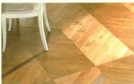
4. Мозаичный паркет составлен из небольших деревянных планок, уложенных бок о бок и закрепленных в виде панелей со стороной от 10 до 30 см. В зависимости от способа настилки паркет может иметь различный рисунок: от самого простого до чрезвычайно сложного.
