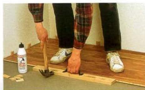
4. Установите последние планки. С помощью планки, поставленной в предпоследнем ряду, и обрезка, прижатого к стенке, определите линию обреза. Сдвиньте планку до этого уровня и отпишите лишнее.
