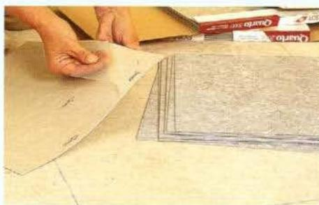
4. В ходе работы постепенно разравнивайте плитки шпателем, большим молотком или, за неимением таковых, скалкой. Эта операция гарантирует хорошее прилипание плиток к полу.
