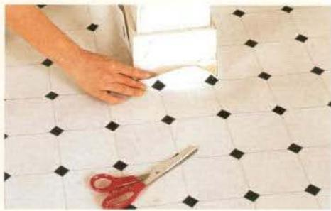
2. Сверните покрытие с одной стороны, чтобы намазать пол клеем. Используйте зубчатый шпатель, чтобы распределить клей ровным слоем. Отогните линолеум.
