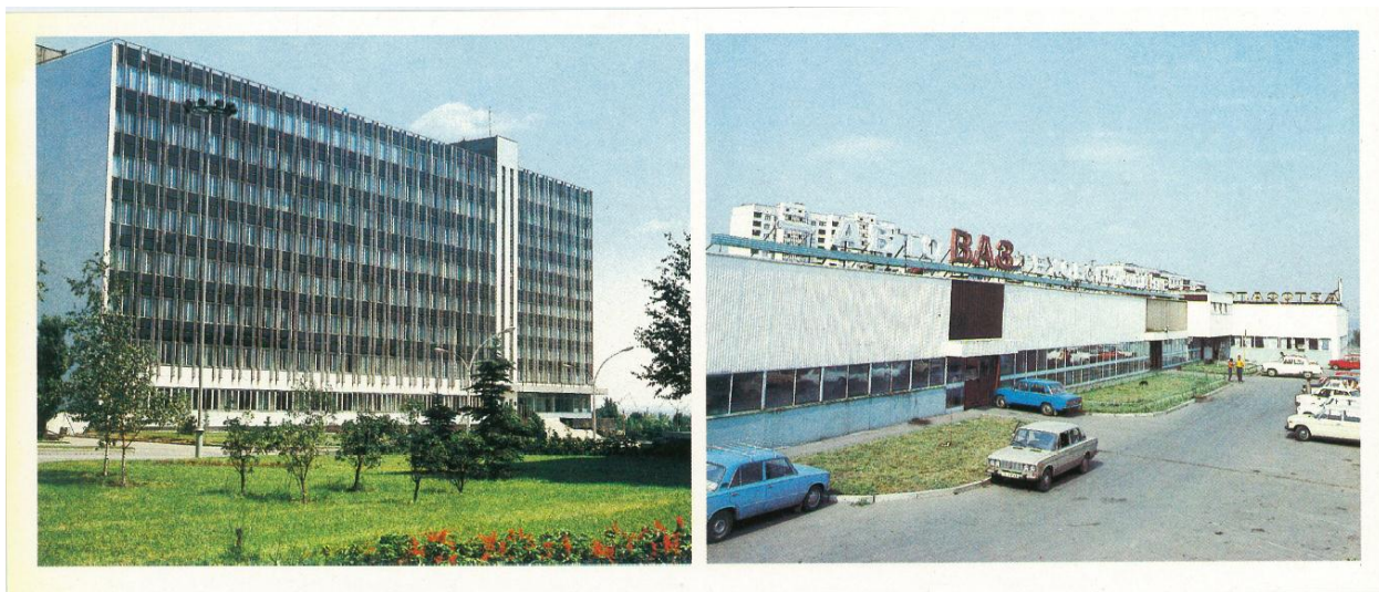
Дом связи Станция автотехнического обслуживания
