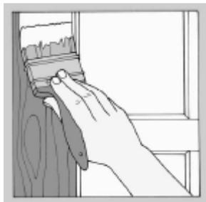
2 Когда вы красите деревянную дверь, всегда старайтесь наносить краску параллельно направлению волокон. Вы заметите, что верхняя, средняя и нижняя горизонтальные балки облицованной панелями двери имеют горизонтальный рисунок волокон.
