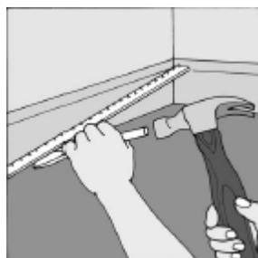
2 Поднимите соединенные между собой ламинатные полы, начиная с того края, где лежит последняя отрезанная полоса. Вкрутите в нее винты с интервалами и используйте плоскогубцы, чтобы захватить их и снять. Затем вернитесь к работе на полу, разделяя полосы и поднимая их.
